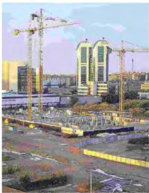
Cantiere in zona Bisceglie / Imagoeconomica
